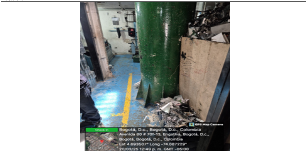
Foto No. 3 – Vista de la base de la estructura en buen estado de mantenimiento
